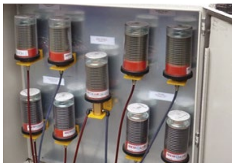
Potravinářský průmysl - zpracování odpadu: skříňka s Memoluby pro mazání ložisek a skříně rotačního fermentoru.
