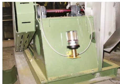
Potravinářský průmysl: mazání ložisek ventilátoru Solyvent Ventec.
