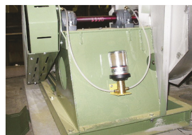
Potravinářský průmysl: mazání ložisek ventilátoru Solyvent Ventec.
