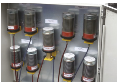
Potravinářský průmysl zpracování odpadu: skříňka s Memoluby pro mazání ložisek a pláště rotačního fermentoru.
